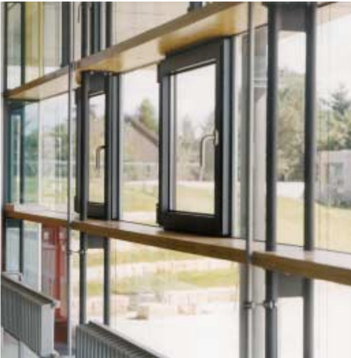
Innenansicht der Fassade: Gut zu erkennen sind die quer laufenden Kertoriegel
