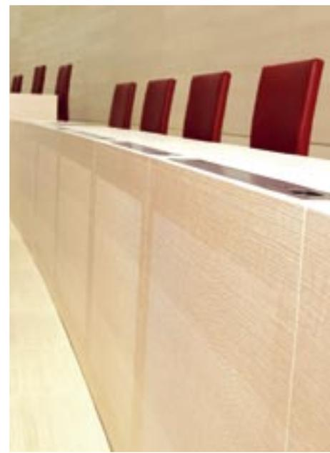
An den Fronten der überaus aufwändigen Abgeordnetentische ist bei genauem Hinsehen die mikroperforierte Oberfläche für die Belüftung zu erkennen (Foto: inseviva)
