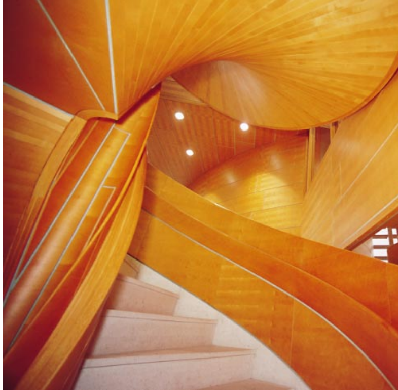
Bilden ein harmonisches Ganzes: schraubenförmige, vier-schalige Außenverkleidung und Treppenuntersicht
