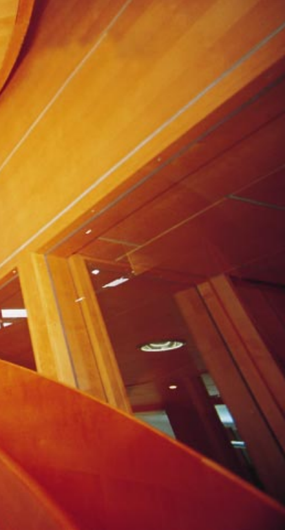
VHB-Referenz der Sonderklasse: Treppenverkleidung in Birke gebeizt und lackiert mit eingelegten Adern aus patiniertem Kupfer in der neuen schwedischen Botschaft, Berlin
