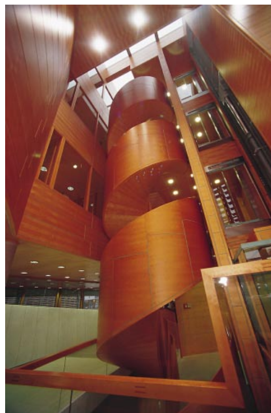
Bilden ein harmonisches Ganzes: schraubenförmige, vier-schalige Außenverkleidung und Treppenuntersicht
